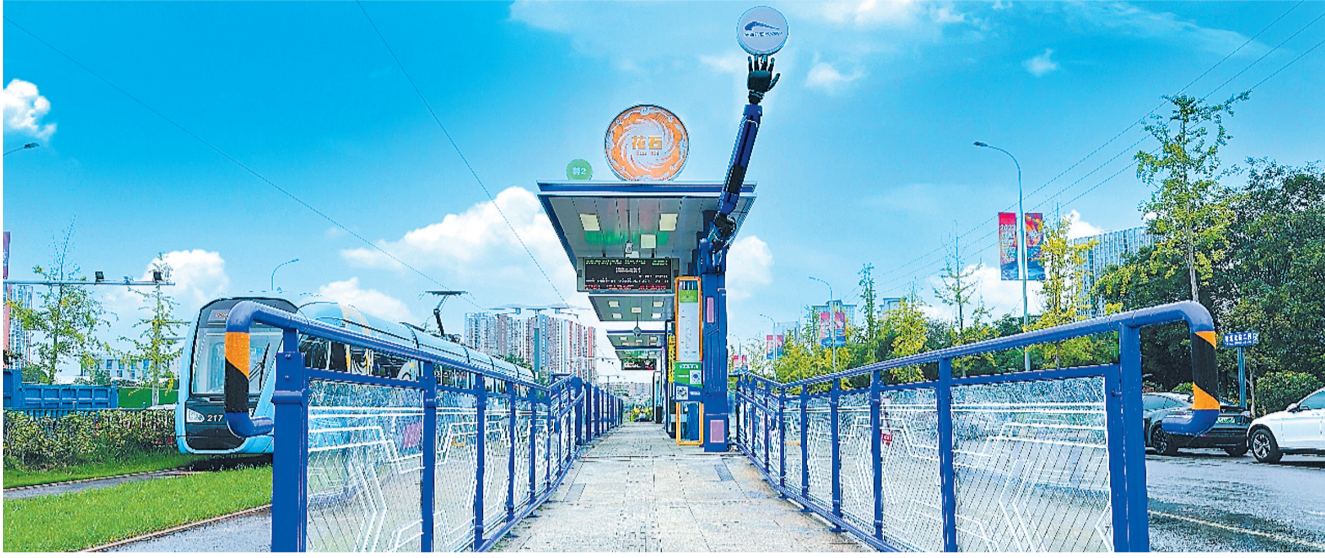
“星遇成都 蓉耀未来”主题车站与不远处的主场馆相呼应,已焕新上线
