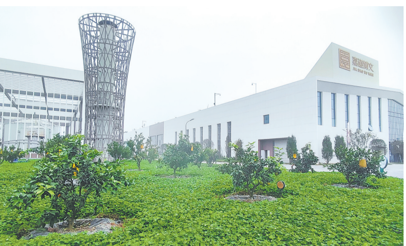
花园式餐厨垃圾无害化处理站
