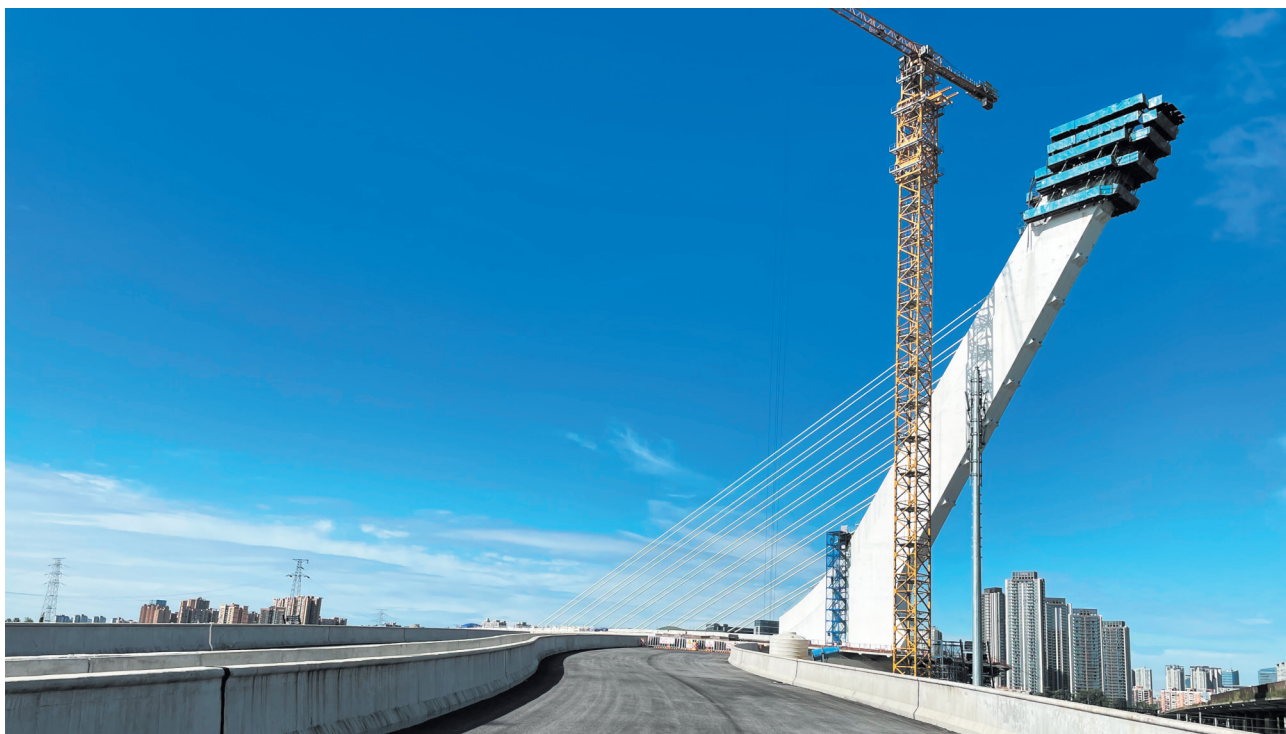
杉板桥路改造工程二标段建设现场
