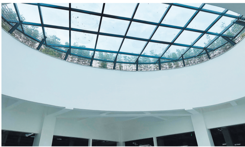
武侯铁佛公园二期地下停车场带中庭采光
