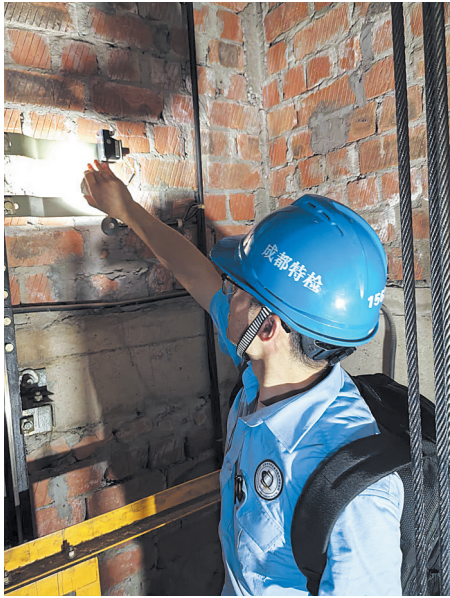
深入现场对电梯进行检查、评估
