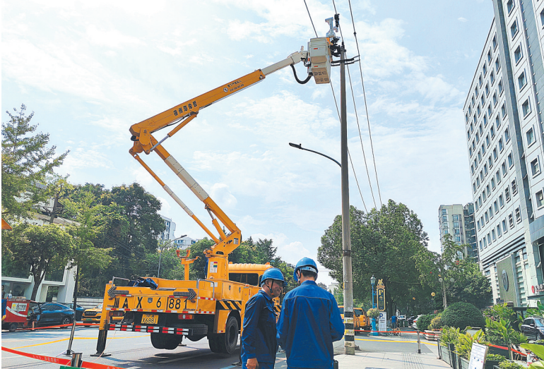
工作人员操作机器人进行配网带电作业
