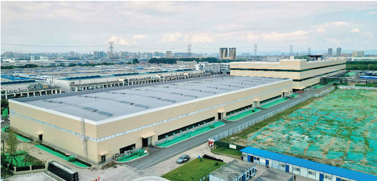
科伦集团在新都的新建总部基地
