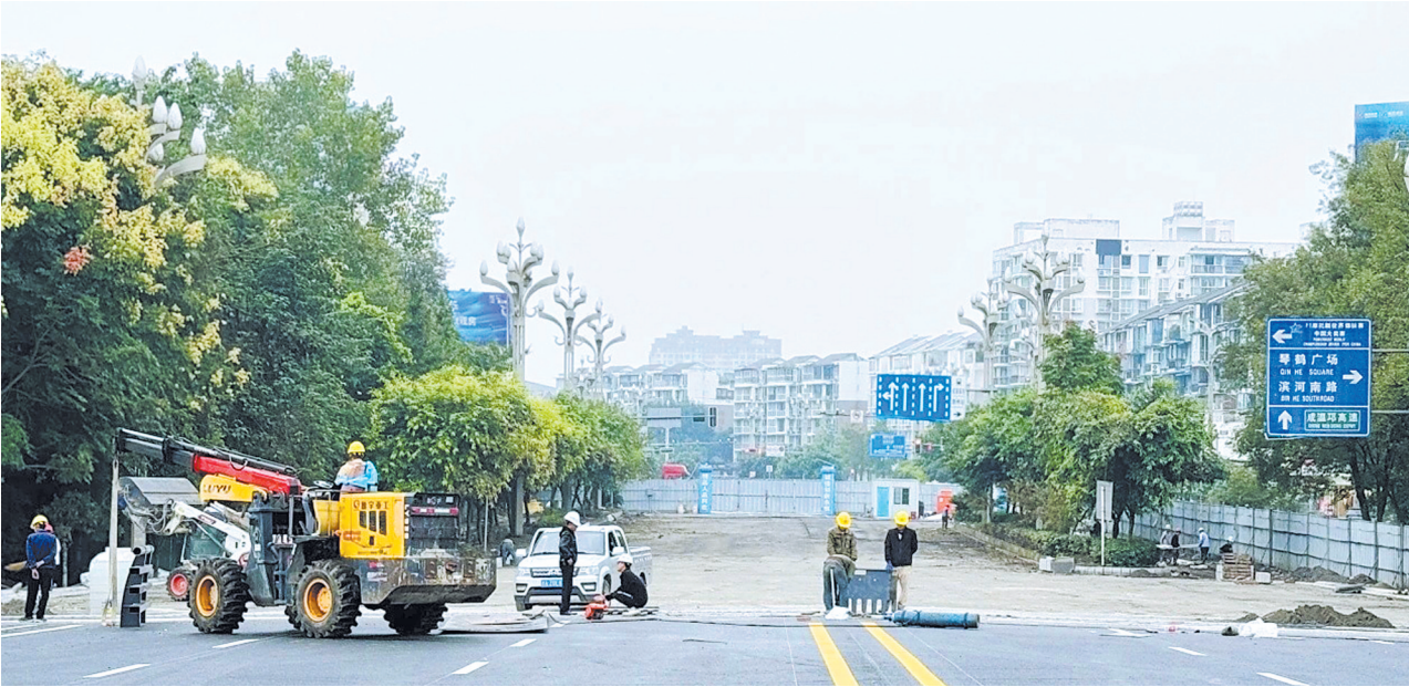
崇州大桥正在进行收尾工作
