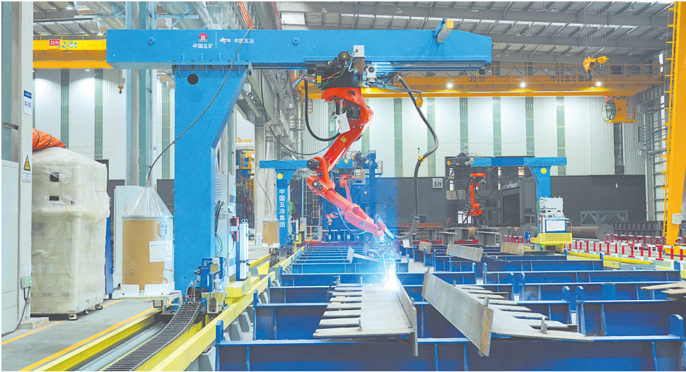
机器臂正在对钢构件细节处进行精准焊接
