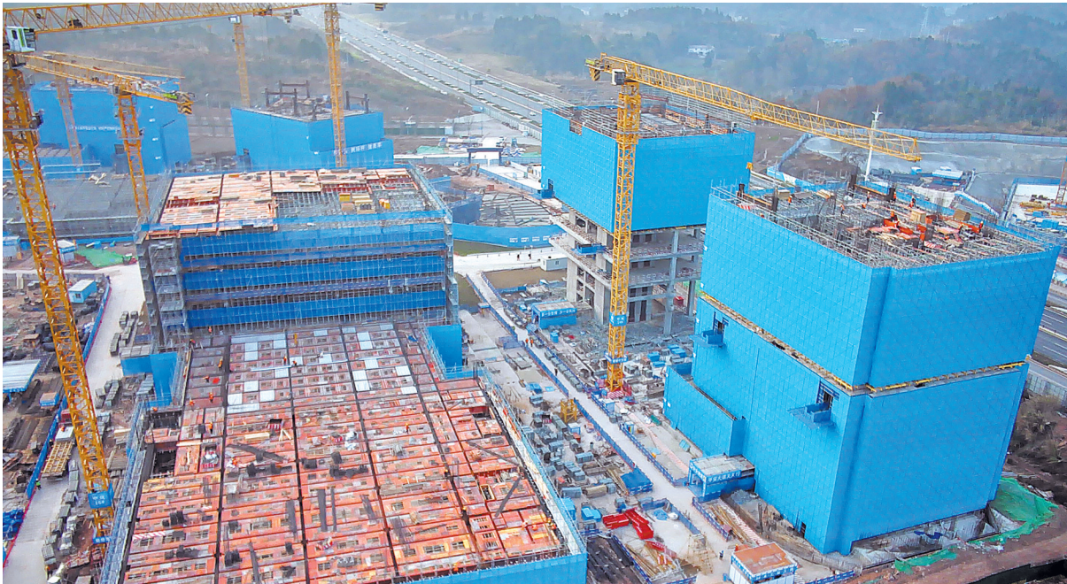
卫星互联网与卫星应用产业园标准厂房实现首栋楼封顶。
