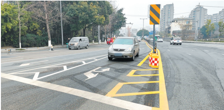
改造后的金辉路万卉三路路口。
