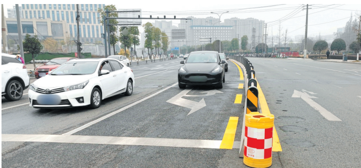
改造后的西货站路万通路路口。
