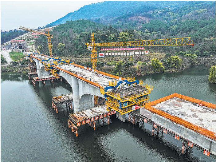
成渝中线高铁玄天湖双线大桥建设项目施工现场(无人机照片)。
