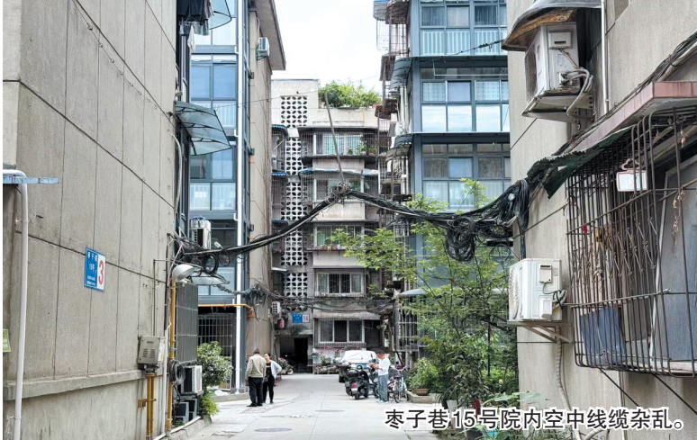
枣子巷15号院内空中线缆杂乱。
