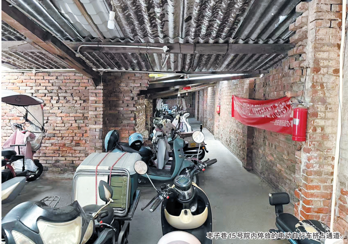
枣子巷15号院内停放的电动自行车挤占通道。
