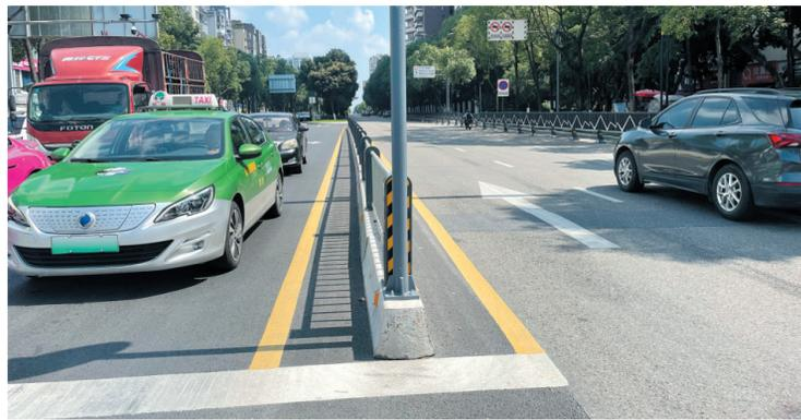
绿化带做切除手术后,增加了转弯加直行的车道,提高了车辆通行效率。
