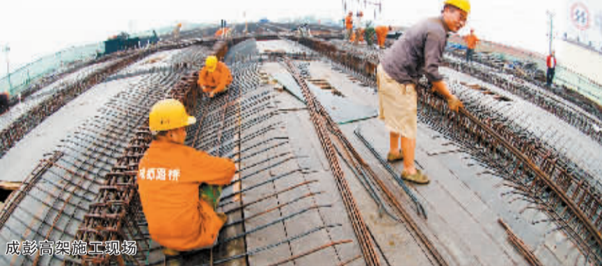
成彭高架施工现场
