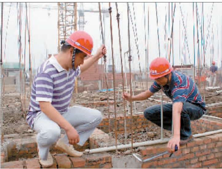
工作人员对重建房屋柱墙的钢筋质量进行抽检
