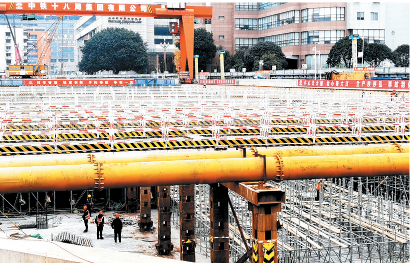
在骡马市站施工现场,车站局部已经快要封顶
