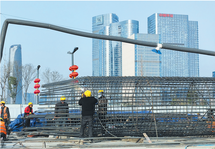
“莲叶桥”项目现场,工人们忙着施工。
