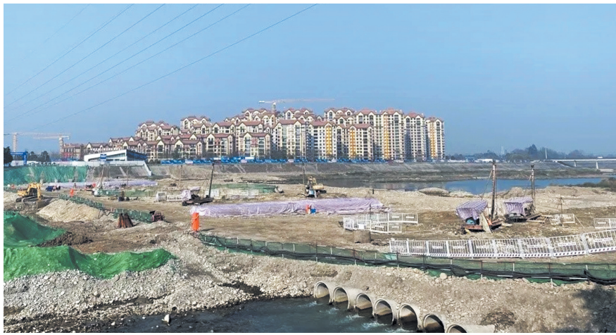
新崇州大桥正在加紧施工
