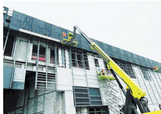
三星堆博物馆新馆项目建设现场，工人们正在忙碌
