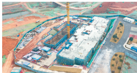
项目建设现场
