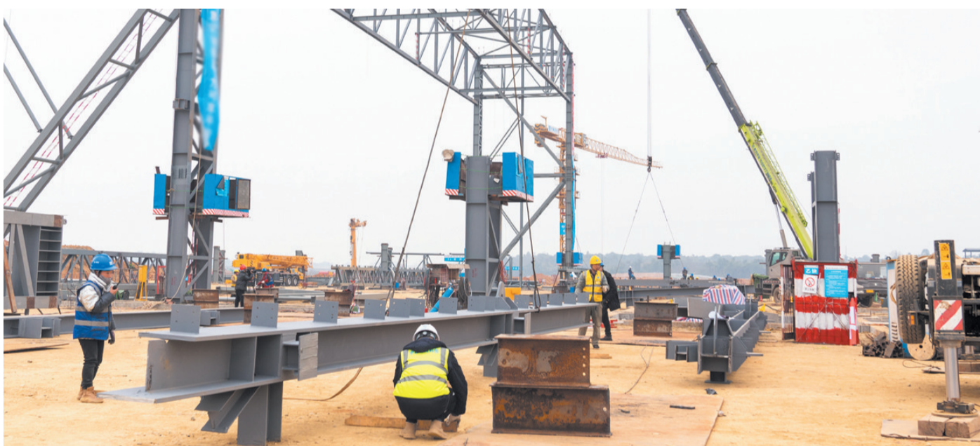
项目现场,工人忙着施工
