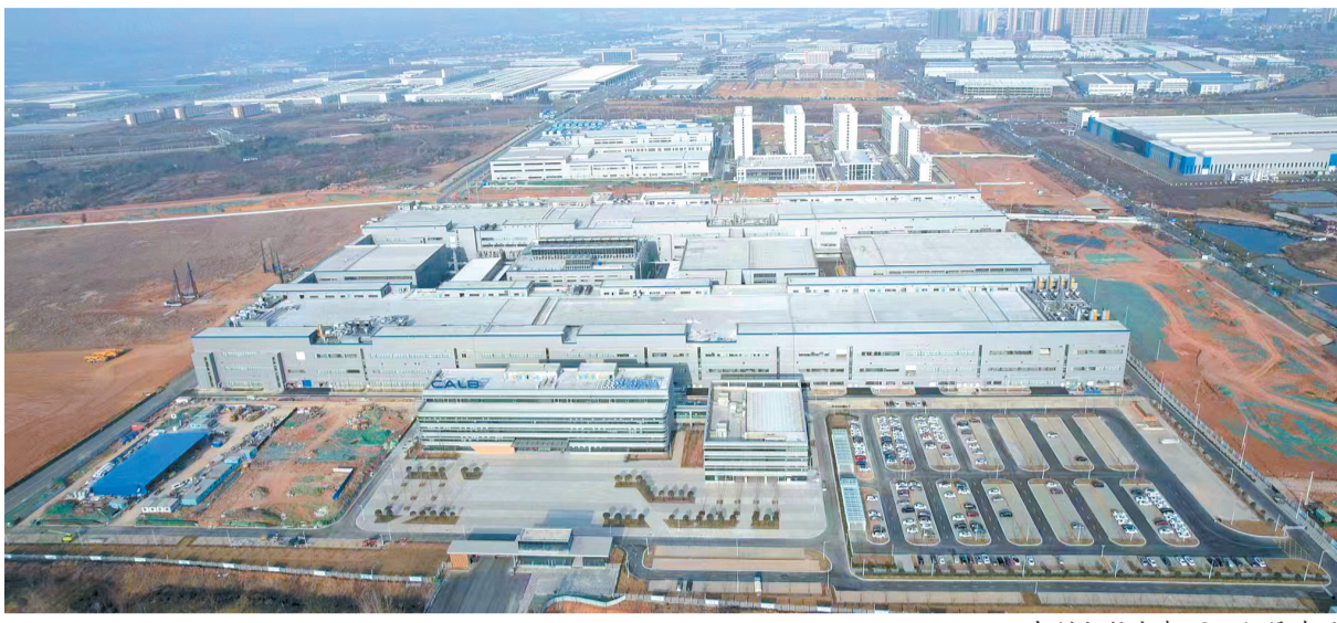
中创新航成都项目加紧建设
