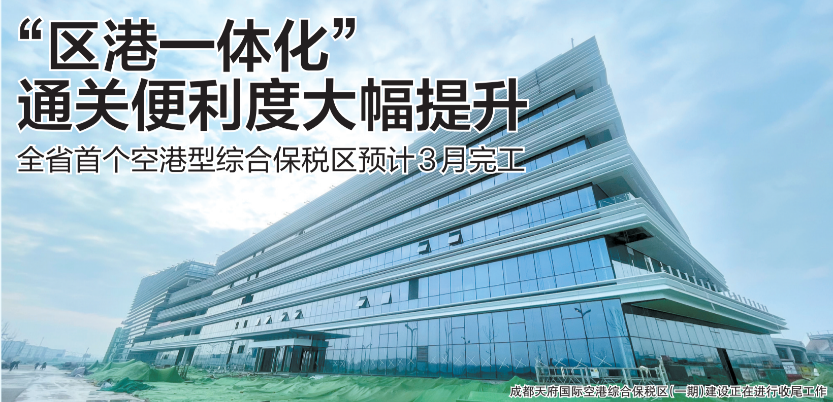
成都天府国际空港综合保税区(一期)建设正在进行收尾工作
