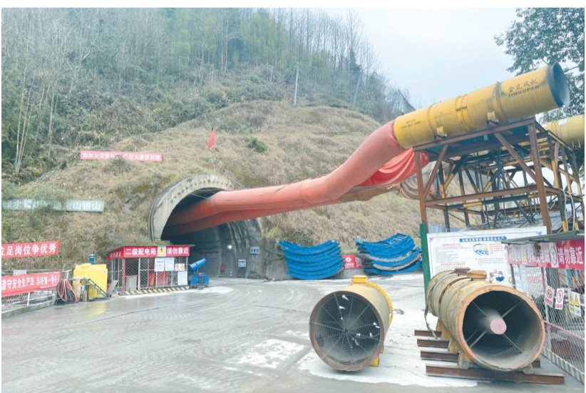
都四山地轨道交通项目DSZQ-2标建设现场
