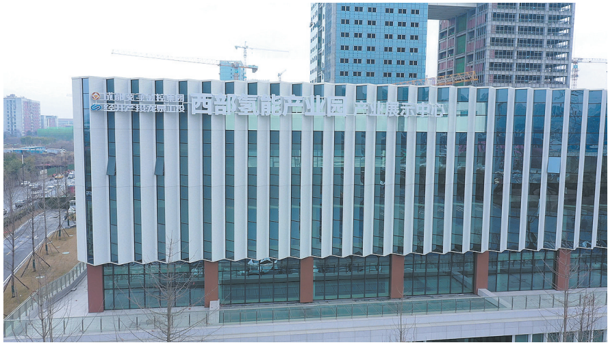
西部氢能产业园项目
