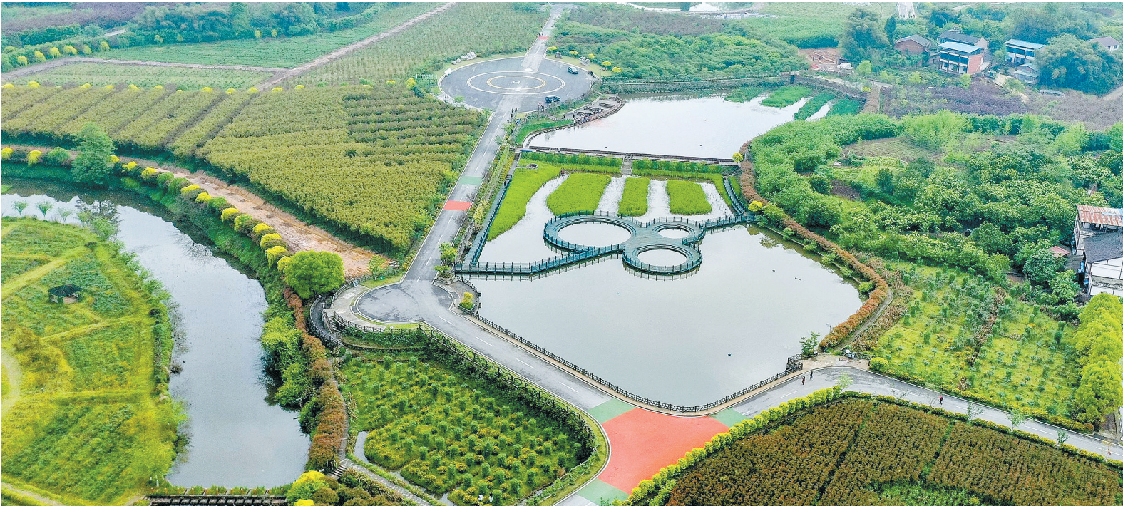
2022年4月5日在四川省华蓥市禄市镇凉水井村生态园拍摄的乡村旅游公路(无人机照片) 新华社发
