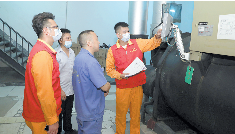
国家电网四川电力（成都高新）连心桥共产党员服务队到商户宣传节约用电
