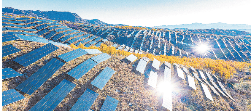
碲化镉发电玻璃电站。 本报资料图片
