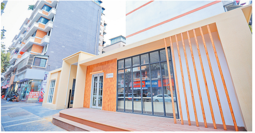
拆墙并院,院内新上岗的“望福驿站”为居民提供政策咨询、法律援助等便民服务
