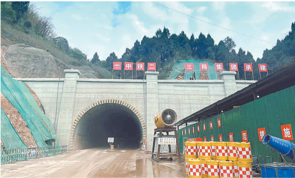
二峨山隧道正加紧施工
