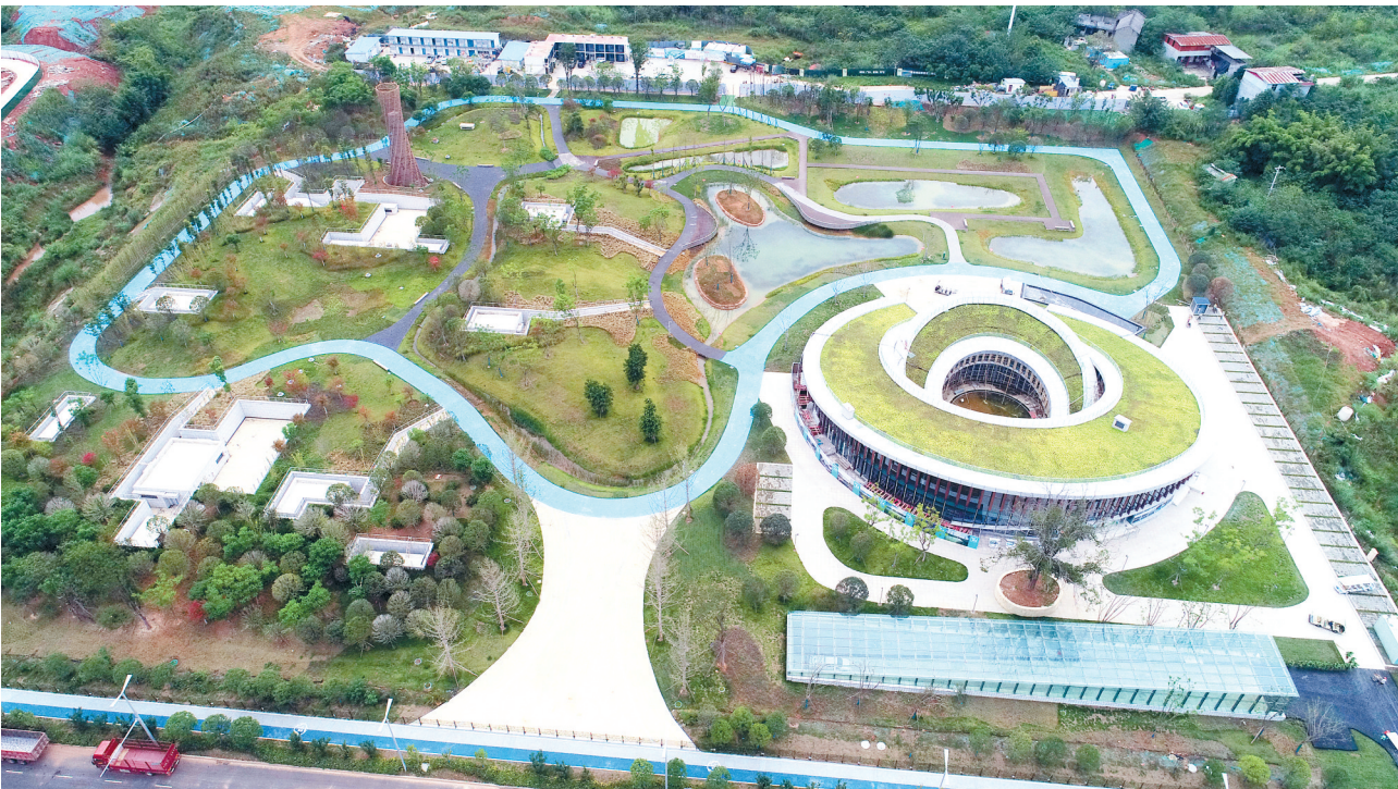
成都东部新区9号再生水厂。
