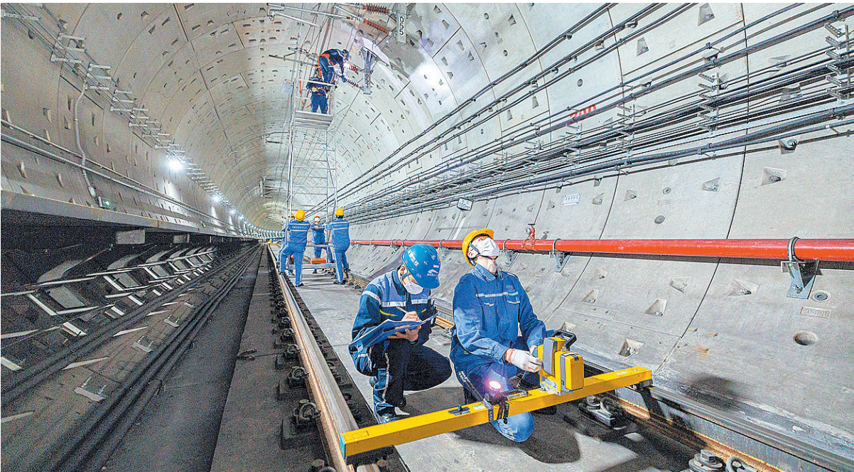
技术人员进行接触网悬挂设备检修作业
