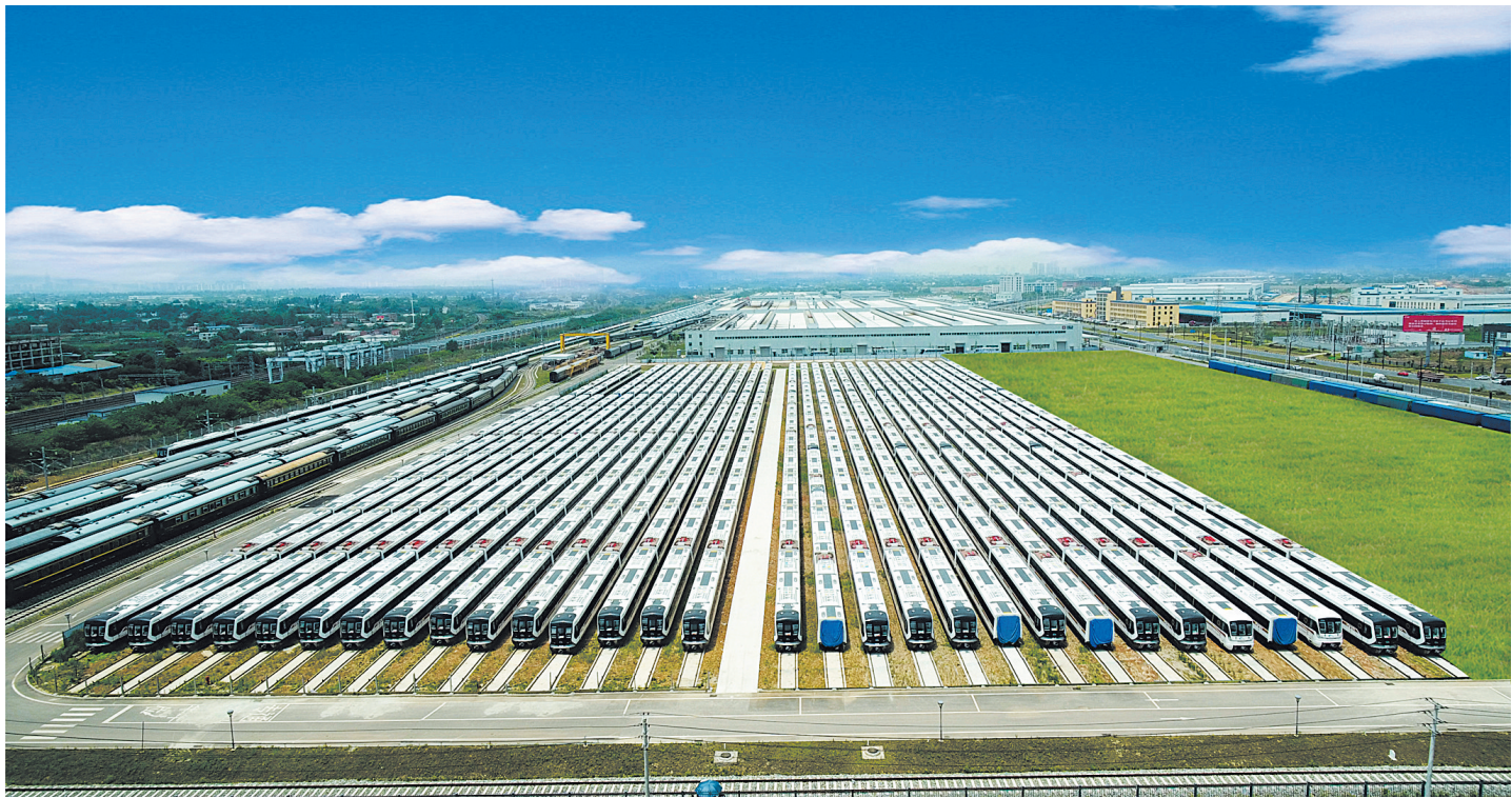
新都现代交通产业功能区 供图:新都区融媒体中心
