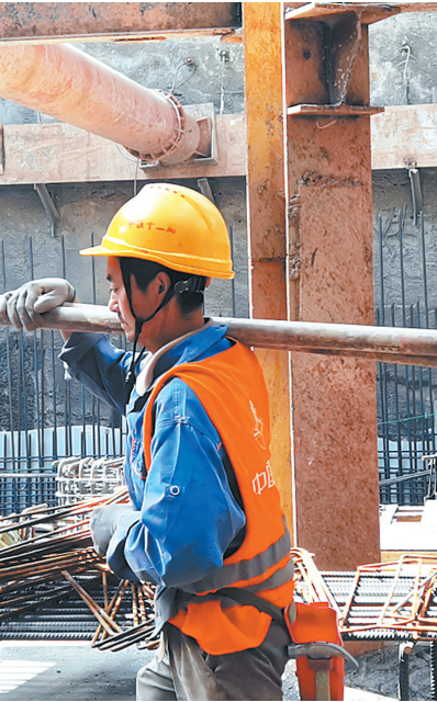
正奋战在施工一线的轨道交通建设者
