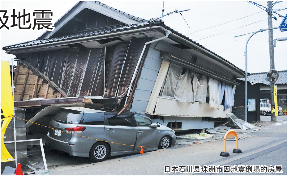
日本石川县珠洲市因地震倒塌的房屋
