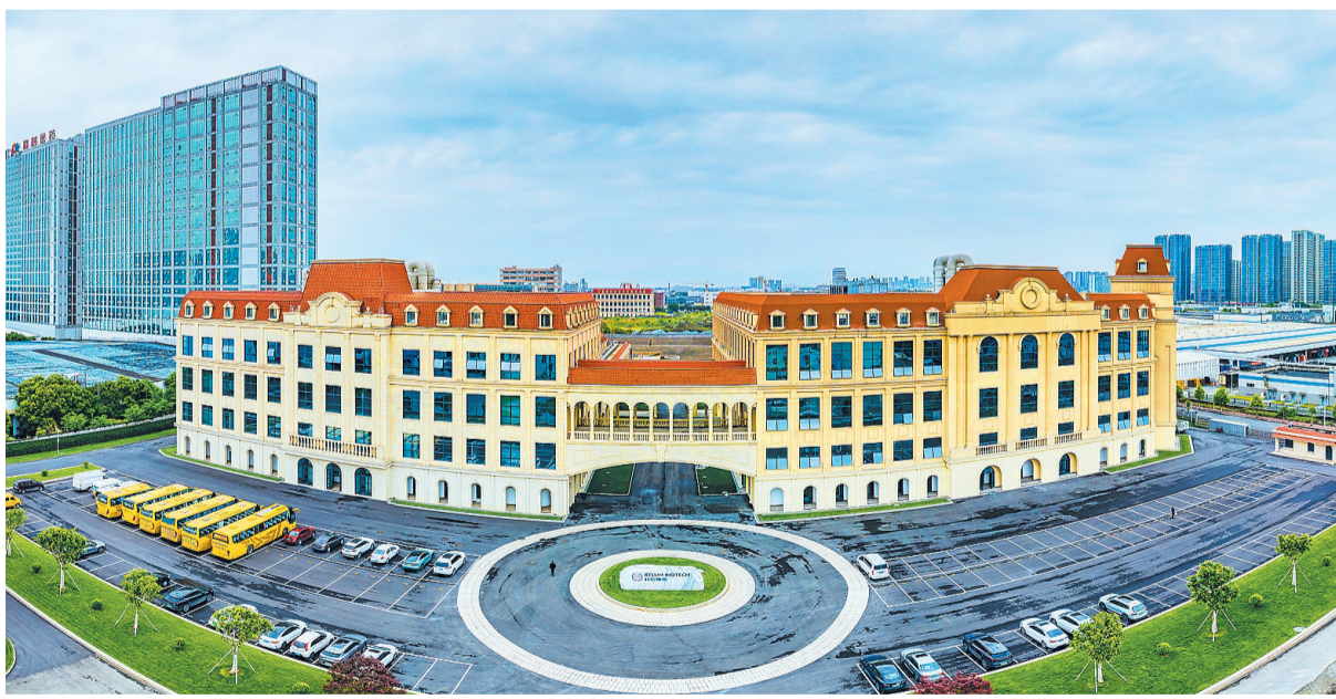
科伦生物医药产业园二期项目
