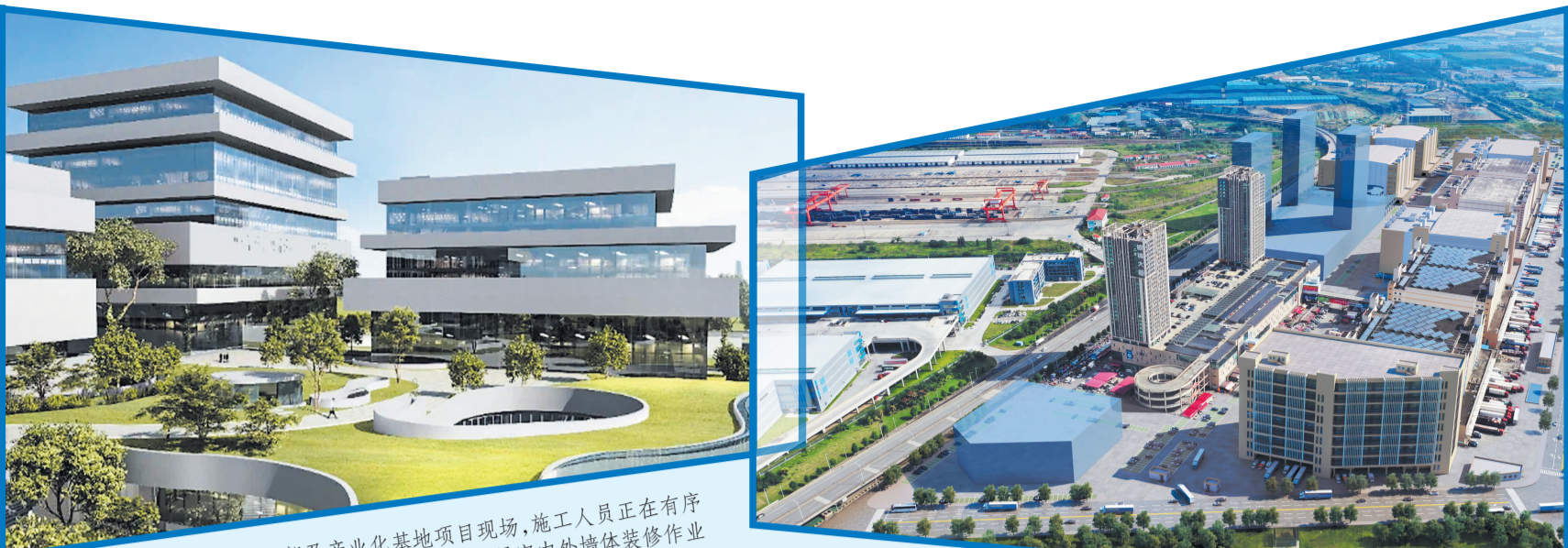
在汇宇创新药物研发总部及产业化基地项目现场,施工人员正在有序作业;在毛家湾片区幼儿园项目现场,正紧锣密鼓开展室内外墙体装修作业……连日来,走进成都天府国际生物城可以看到,各大项目现场机器轰鸣,车辆穿梭,呈现一片火热的建设场景。 作为成都“三个做优做强”重点片区之一,成都天府国际生物城不断发展,聚焦重点片区强功能、提能级,持续发力项目集群建设,围绕产业建圈强链加快引育新增长点和竞争新优势,推动医药健康产业加快发展。
