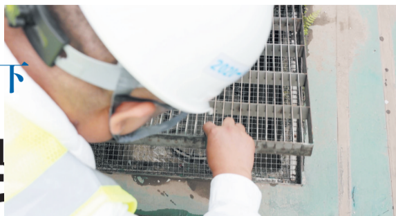
罗皓正在游泳跳水馆楼顶检查排水功能是否正常
