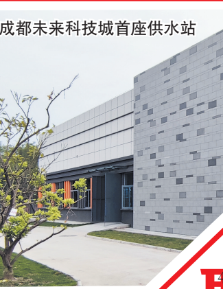
成都未来科技城首座供水站
