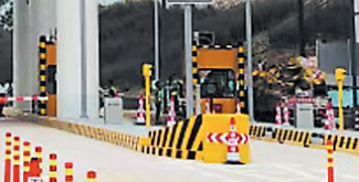
天府机场高速公路未来科技城收费站
