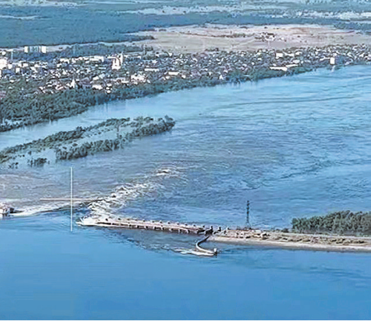
卡霍夫卡水电站遇袭后现状
