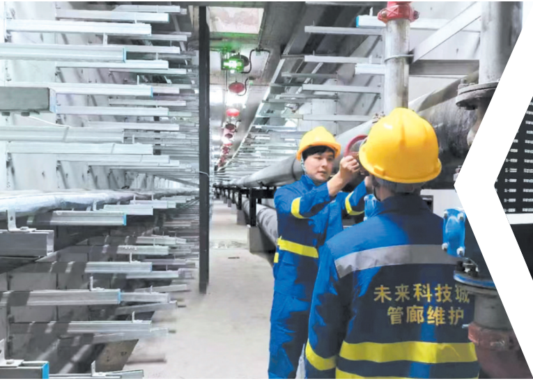
巡查员检查地下综合管廊
