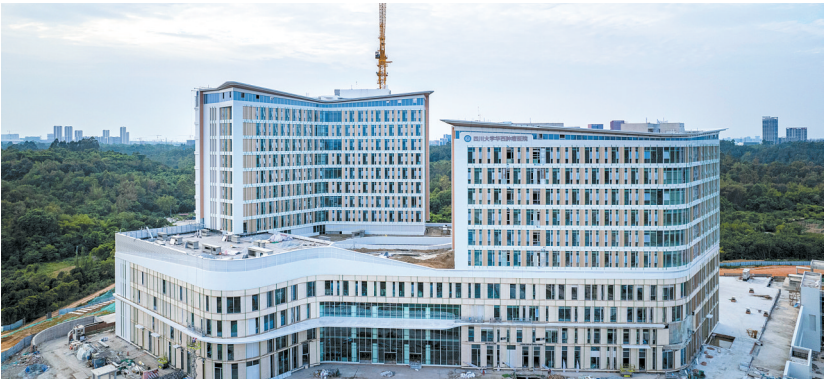
华西国际肿瘤治疗中心(重离子质子)项目一期医疗楼
