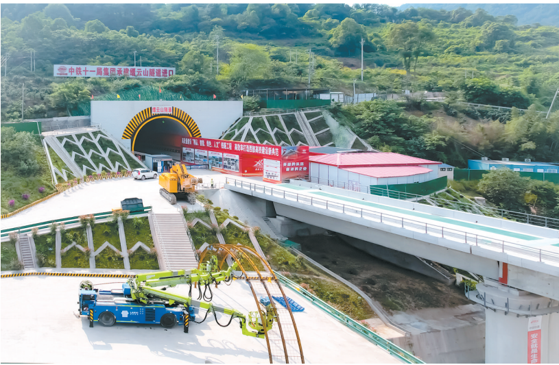
渝昆高铁缙云山隧道
