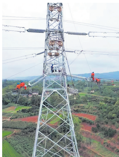
成都大林500千伏变电站220千伏配套工程高空施工作业现场。
