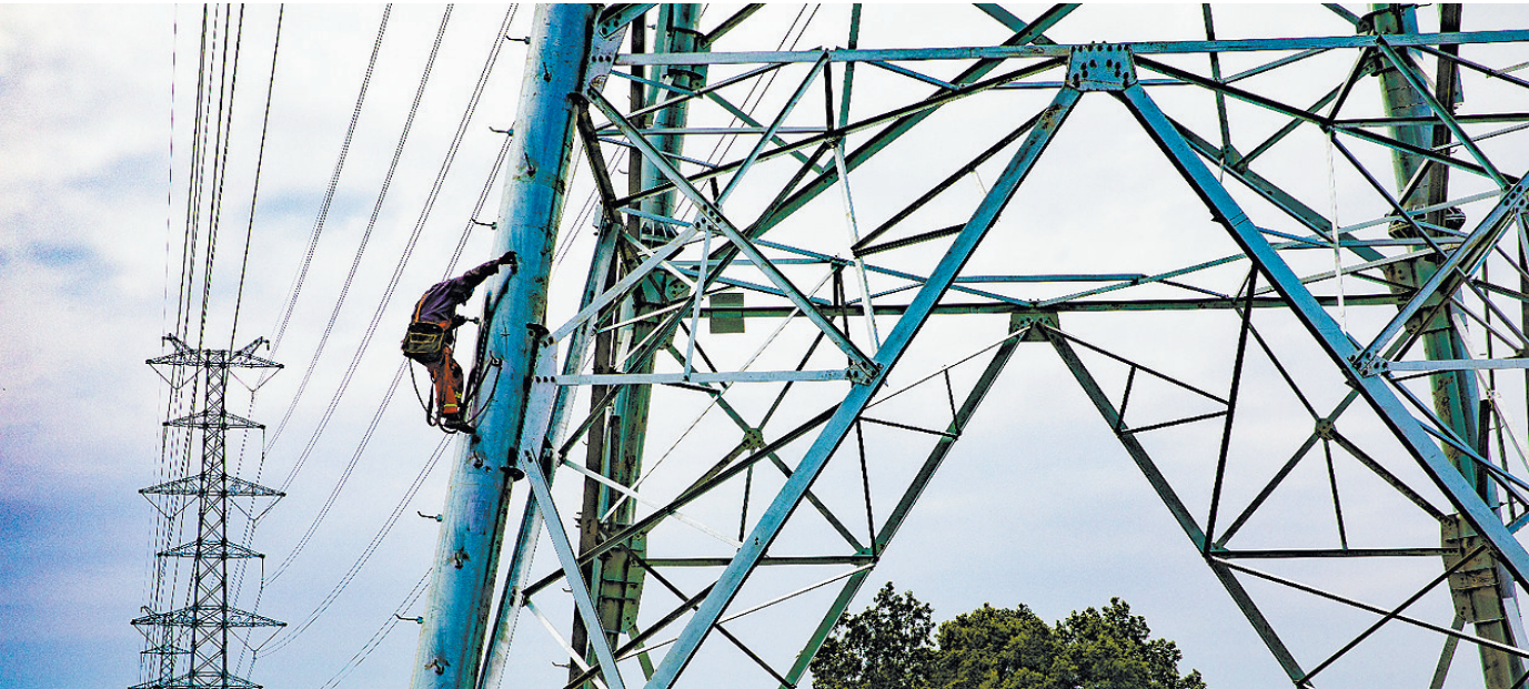
国网成都供电公司电网建设人员登塔开展紧线及附件安装工作 受访单位供图
