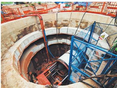
无人驾驶的顶管机正在作业
