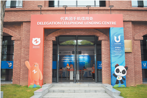
提供手机租借的大楼位于大运村一处风景优美的湖畔,红墙外观十分醒目
