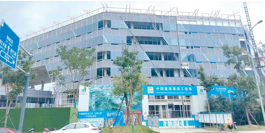
交子金融梦工场四期正在进行幕墙安装
