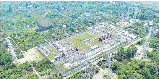
220千伏玉提变电站线路配套工程建设现场
